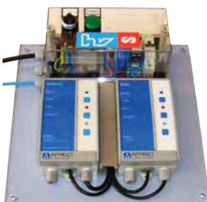
Mit der elektrischen Steuerung für Altölpumpen ist sichergestellt, dass Altöle aus Grubenwannen, Altölschienen u. ä. automatisch abgepumpt werden. Das Gerät schaltet nach Beendigung des Pumpvorganges selbständig ab.
